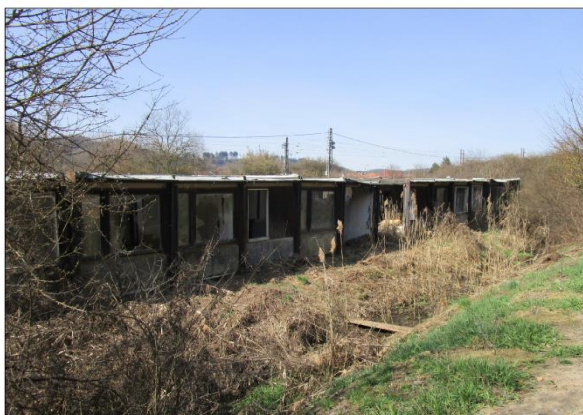
Obr. č. 23: Skládka v ulici Tišnovka
